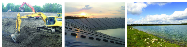
Fotos fra hæftet "Thinking about an irrigation reservoir?".
